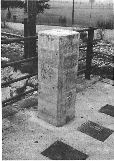
Bild 1: Pfeiler BN auf dem westlichen Widerlager der Straßenbrücke Widnau - Diepoldsau
