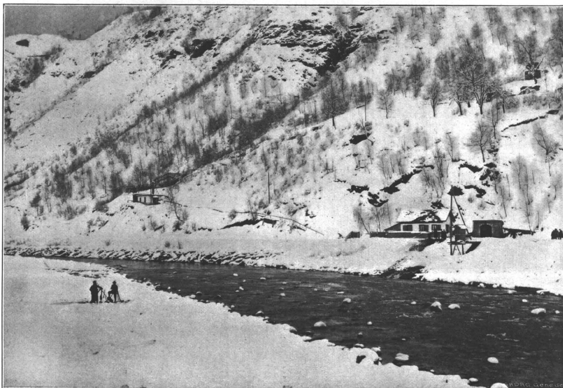
FIG. 32. — Vue générale de la portée du fil de 72 mètres. (A droite la porte d'entrée de la galerie de direction nord).
