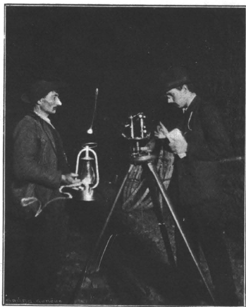
FIG. 28. — Station de théodolite pour l'alignement.
