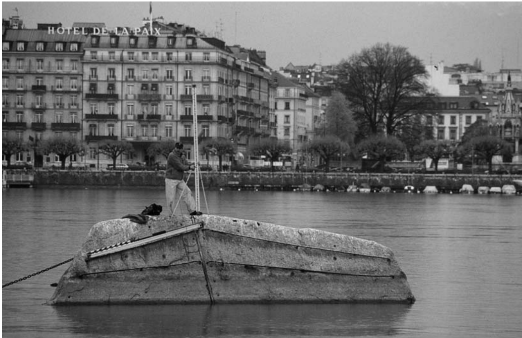
Abbildung 6.2-2: Repère Pierre du Niton im Hafenbecken von Genève. Höhenfundamentalpunkt des bisherigen Bezugssystems CH1903 und des Höhenbezugsrahmens LN02.
