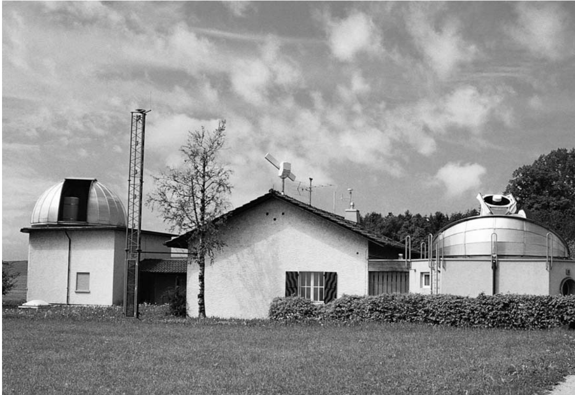
Abbildung 6.2-3: Geostation Zimmerwald Z 0 : Fundamentalpunkt der Bezugssysteme CHTRS95 und CH1903+ der neuen Landesvermessung der Schweiz.
