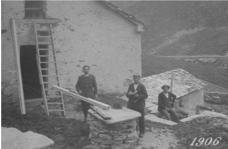
Abbildung 5.1-2: Feldvergleich der Miren mit Stahlmassstab am Grossen St. Bernhard (1906)
